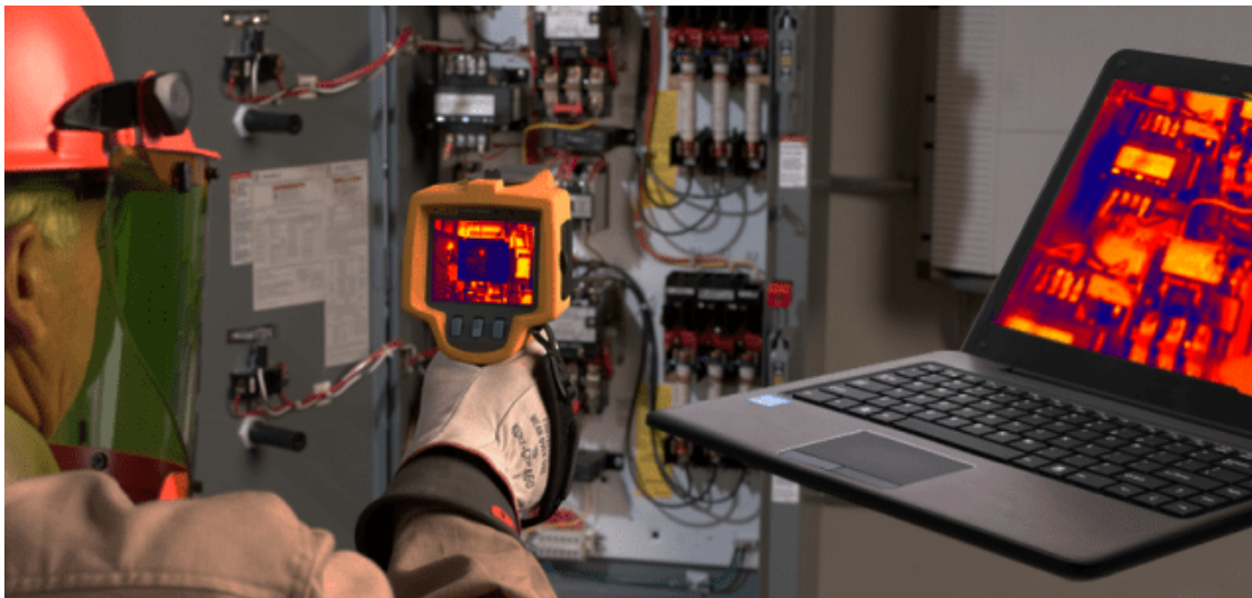
Рисунок 20. Пример проведения тепловизионного контроля электрошкафа
